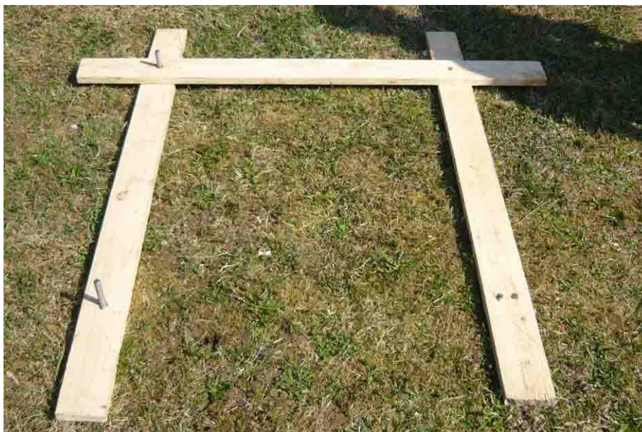
Фото 5: Установка основания. Этап 2
