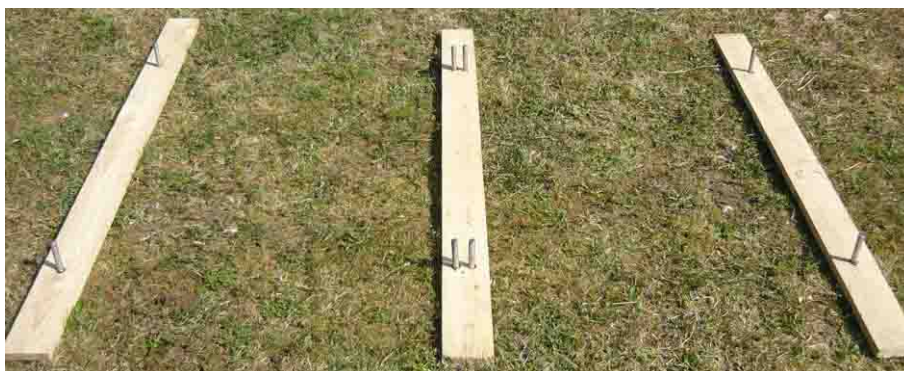
Фото 6: Установка основания. Этап 3
