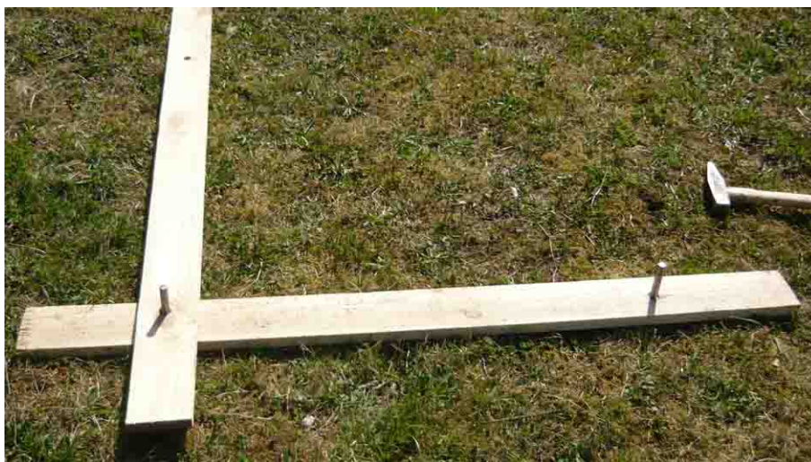
Фото 4: Установка основания. Этап 1
