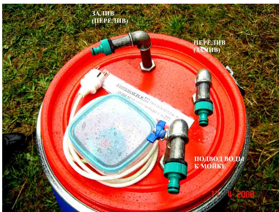
Фото 17: Подключения к емкости для воды
