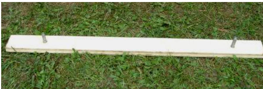
Фото 6: Закрепление опорной доски анкерами
