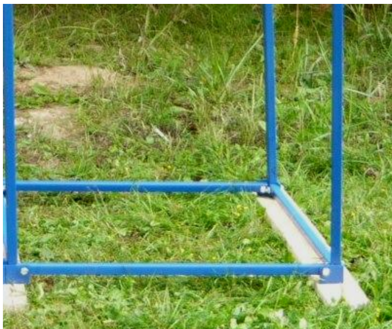
Фото 8: Сборка металлического каркаса
