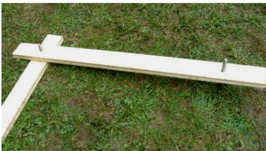
Фото 7: Закрепление второй опорной доски
